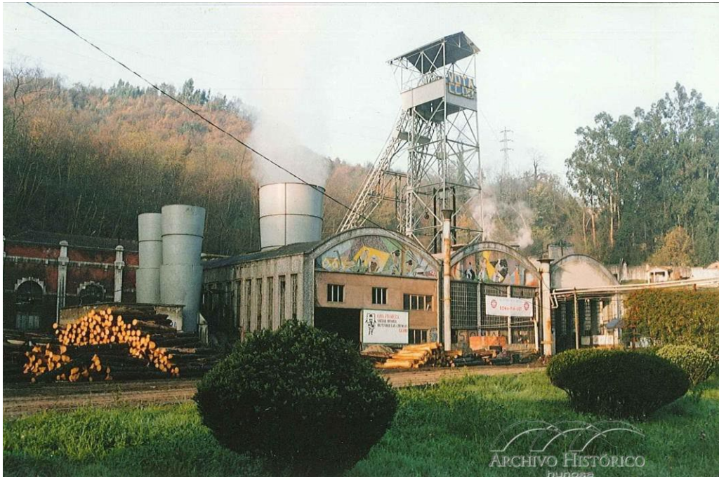
Fotografía tras la colocación del difusor del ventilador. Archivo Histórico de Hunosa (1996)
