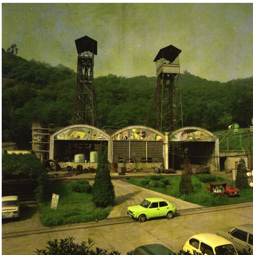
Fotografía con los dos castilletes finales y nuevo pabellón de embarque del Pozo Fondón. Archivo Histórico de Hunosa (fotografía de los años 70)
