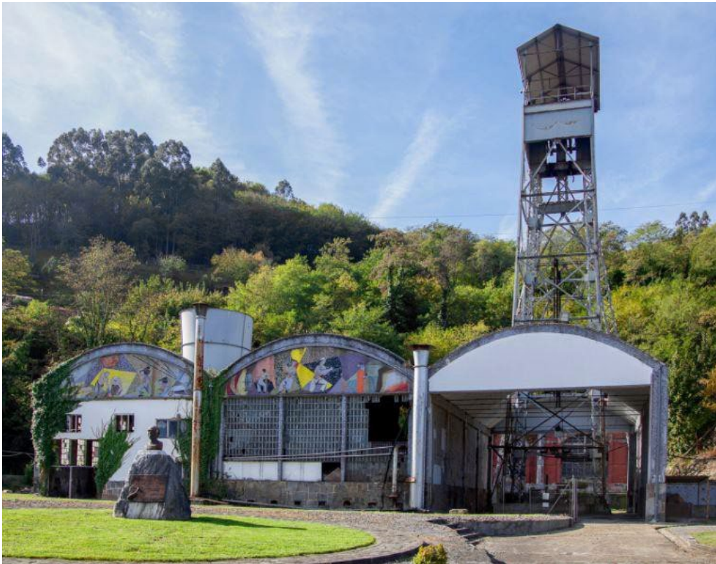
Fotografía con los dos castilletes finales y nuevo pabellón de embarque del Pozo Fondón. Década 2000 - 2010
