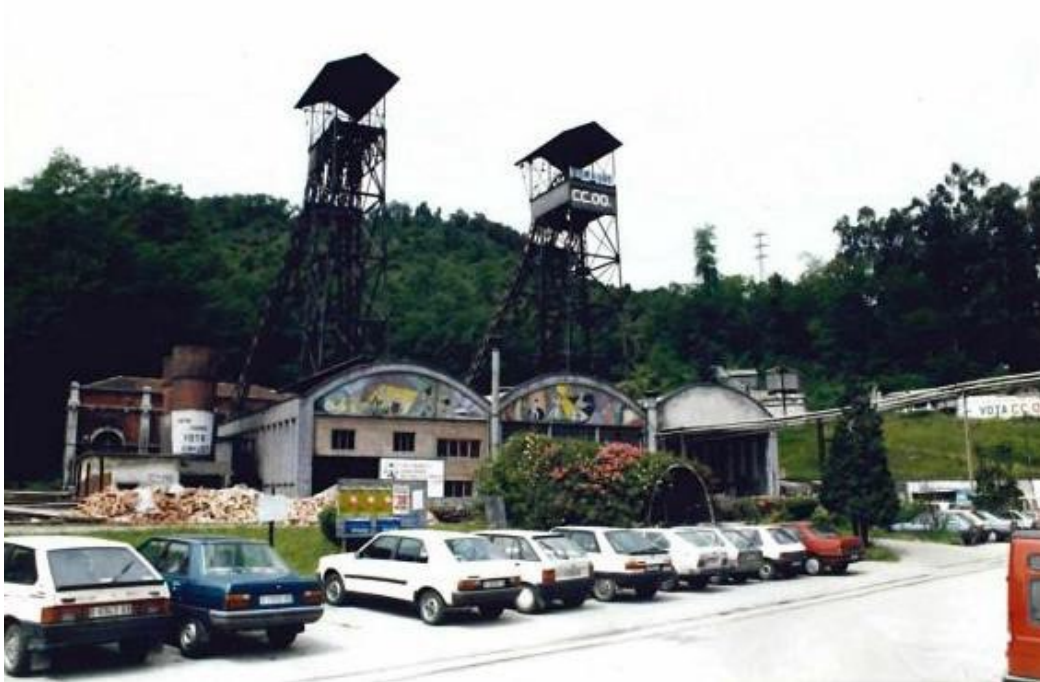
Fotografía con los dos castilletes finales y nuevo pabellón de embarque del Pozo Fondón. Archivo Histórico de Hunosa, tras la explosión del compresor (fotografía de los años 80). En esta fotografía se ve como el tercer mosaico del año 1957 desaparece
