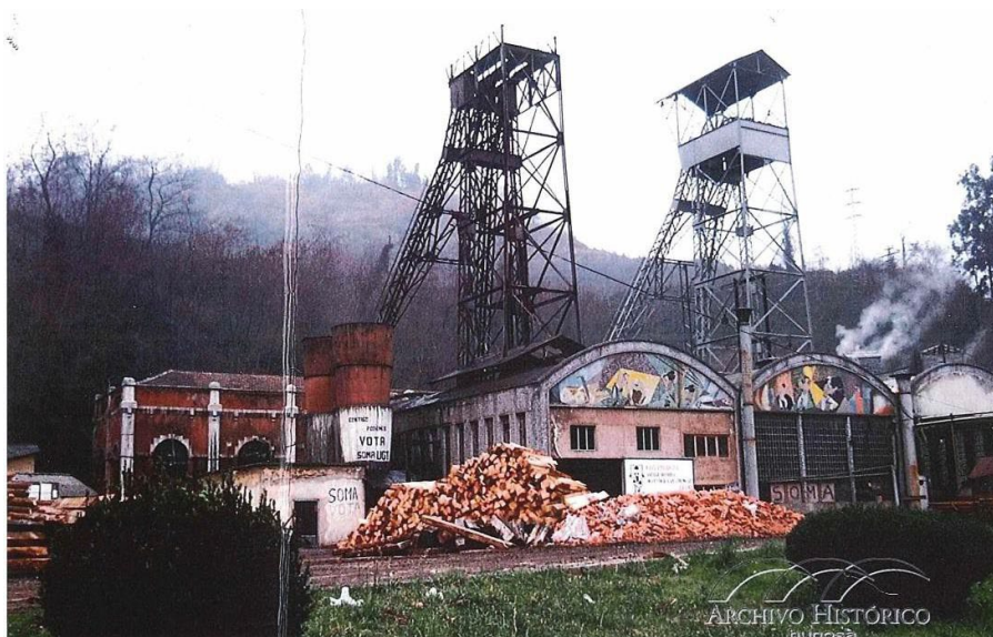
Fotografías del desmantelamiento del pozo auxiliar (1992-1993)
